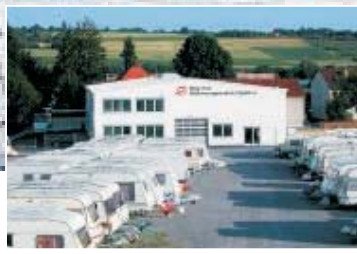
Der Betrieb: Heute steht ein modernes Servicegebäude auf dem Platz in Steinheim an der Murr.
